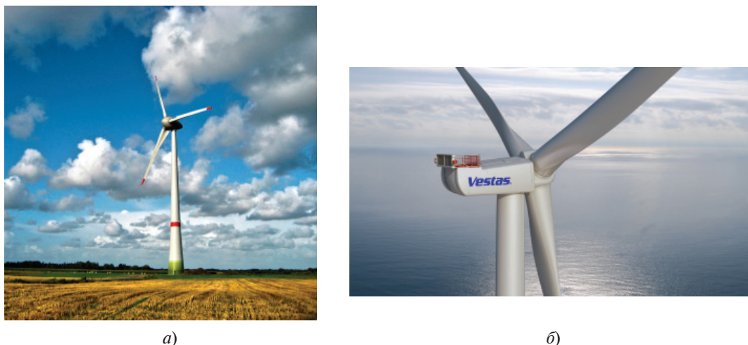
Рис. 4. Ветрогенераторы Enercon E-126 (а) и Vestas V-164 (б)
